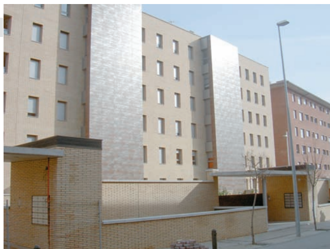
Edifici plurifamiliar aïllat de 54 habitatges (fase A) a Vic, de Jordi Comas i Anna Pont
