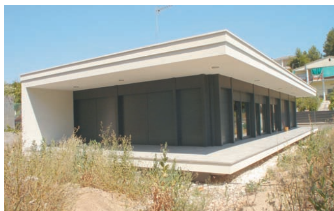
Habitatge unifamiliar aïllat a Sant Vicenç de Castellet , de Ramon Subirana i Arturo de Visa
