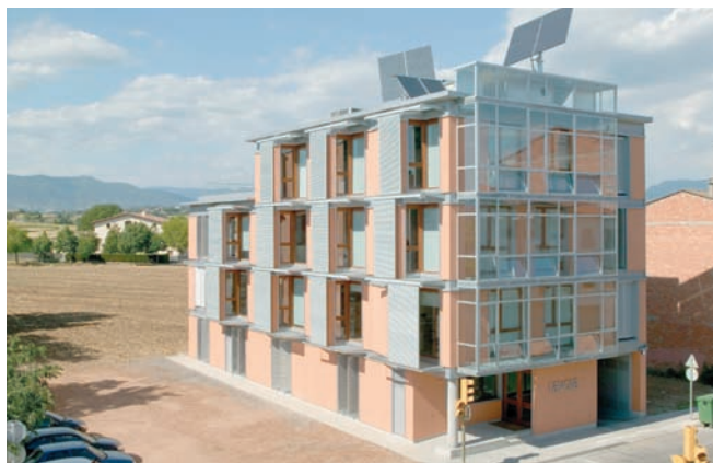
L'ecoedifici. Edifici d'oficines d'ús privat a Manlleu, d'Ecosit Arquitectes, SL, (Miquel Sitjà)
