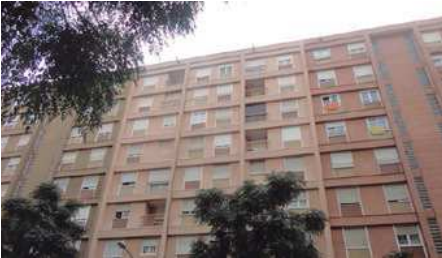
REPARACIÓ LESIONS ESTRUCTURALS SABADELL Data: 1999 • Equip: Jordi Caveró
