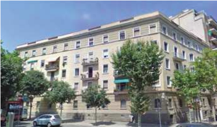
REHABILITACIÓ ESTRUCTURAL BARCELONA Data: 2005 • Equip: Jordi Caveró
