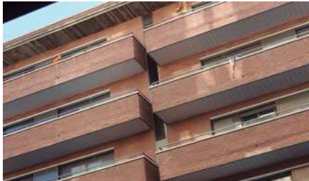
EDIFICI PLURIFAMILIAR ENTRE MITGERES MANRESA Data: 1998 • Superfície: 2.345m²
