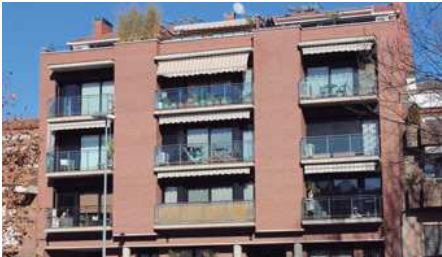
EDIFICI PLURIFAMILIAR ENTRE MITGERES MANRESA Data: 1999 • Superfície: 1.678m²
