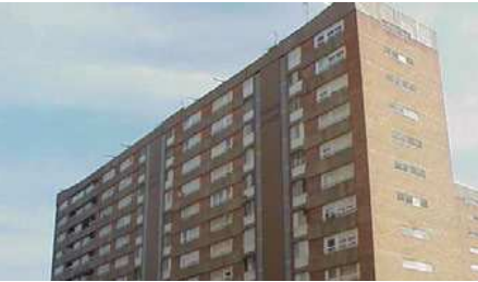
REPARACIÓ FAÇANES BARCELONA Data: 2003 • Promotor: Colonial
