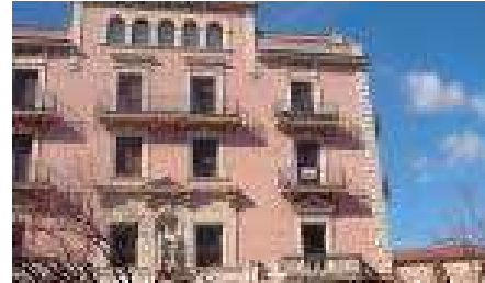
REHABILITACIÓ ESTRUCTURAL GRANOLLERS Data: 1999 • Promotor: La Caixa
