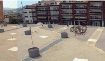
COBERTA DEL MUSEU DE LA TÈCNICA MANRESA Data: 2009 • Superfície: 3.199m²
