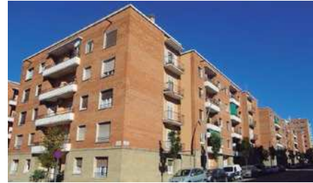
REHABILITACIÓ 100 HABITATGES MANRESA Data: 1996 • Equip: Victor Seguí
