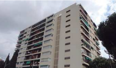
REHABILITACIÓ 80 HABITATGES TERRASSA Data: 1999 • Promotor: C.Proprietaris • Equip: Victor Seguí
