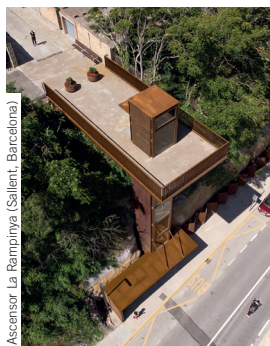
Ascensor La Rampinya (Sallent, Barcelona)
