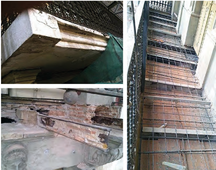
Fig. 24.5. Sustitución total de la losa del balcón con grietas indicativas de perfiles fuertemente oxidados. Los nuevos balcones se forman con nuevos perfiles IPN, piezas cerámicas huecas machihembradas a modo de solera y hormigón con chapa armada superior.
