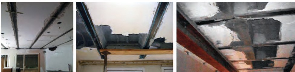
Fig. 15.3. En la foto izquierda y central, disposición de bandas de fibra de carbono para el refuerzo de viguetas. El tablado apuntalado en el extremo de las viguetas evita el despegue de las bandas durante la polimerización de la resina de adherencia en los lugares de máximos esfuerzos rasantes (efecto spalling). En la foto de la derecha, refuerzo a los esfuerzos de corte mediante macizado de los entrevigados en los extremos de las viguetas pretensadas, junto a una jácena plana con inercia reforzada por el perfil HPN inferior.
