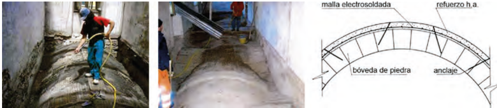
Fig. 25.9. En las fotos, ejemplo de puesta en obra de refuerzo a base de hormigón armado. En el gráfico, sección de regresado de hormigón armado anclado a una bóveda de piedra.
