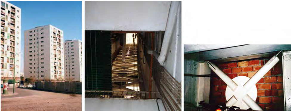
Fig. 30.2. Edificios de 13 plantas con estructura porticada de hormigón armado reforzado siguiendo unas pautas similares al de la figura anterior, en pórticos situados en el interior del edificio.
