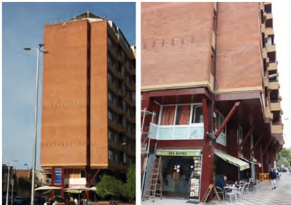
Fig. 19.5. Refuerzo con perfiles metálicos de los tramos en voladizo del primer forjado que soportan las cargas transmitidas a través de las fachadas.
