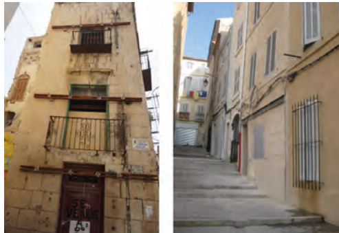
Fig. 2.5. Ejemplos de disposición de perfil metálico a modo de anclaje conjunto de los atirantamientos transversales. En el edificio de la foto de la izquierda, la solución se plantea como medida provisional preventiva; en el de la derecha, como solución definitiva.
