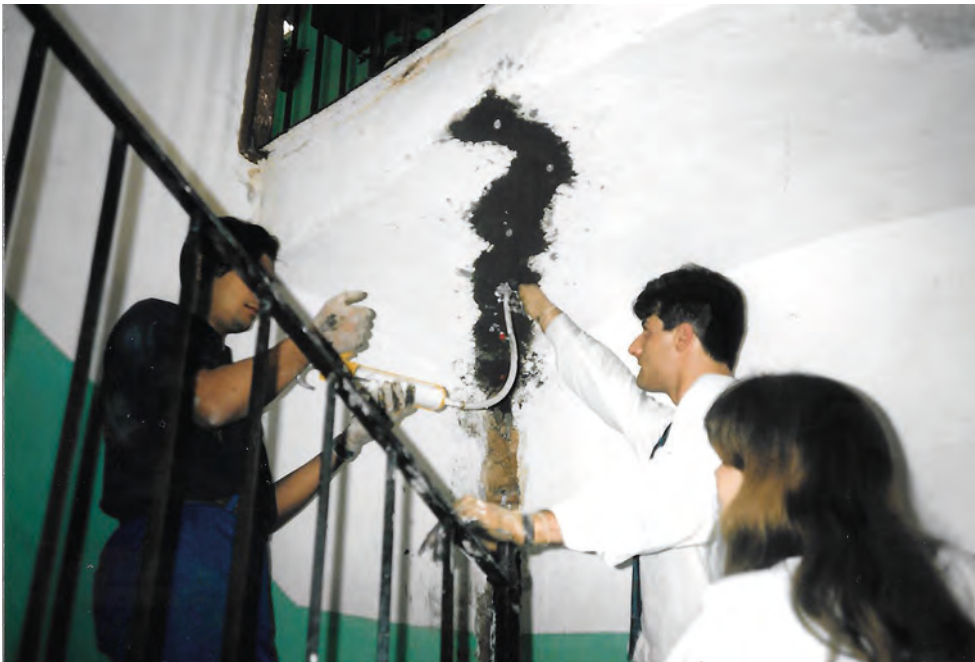
Fig. 26.2. Puesta en obra de un procedimiento de inyección en una bóveda cerámica rota por un movimiento general del edificio.
