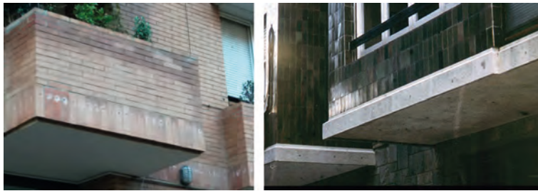
Fig. 41.4. Ejemplos de refijación de las piezas cerámicas o de piedra natural mediante clavado directo al canto del forjado, sin extracción previa.
