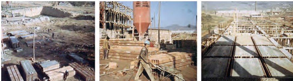
Fig.17-2. Formación de placas conformadas a pie de obra con casetones y nervios cerámicos. Transporte y posicionado de las placas.
