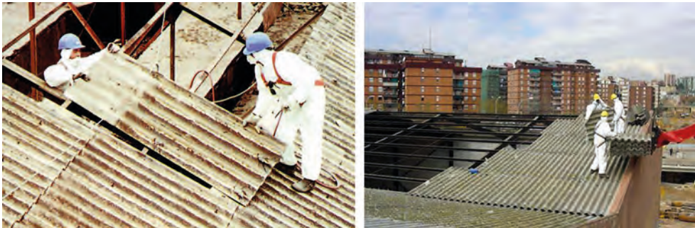
Fig. 54.2. Ejemplos del proceso de sustitución de las placas de fibrocemento con amianto existentes.
