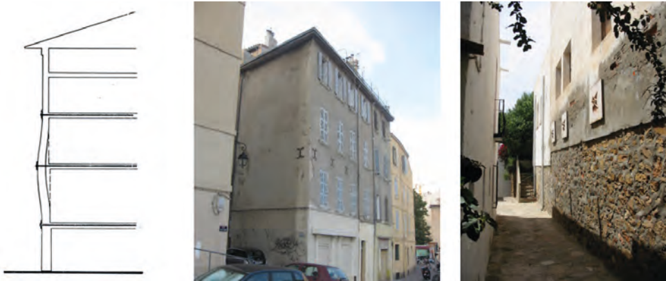
Fig. 2.4. Ejemplos de atirantamiento de muros exteriores de fachada. Obsérvese las placas de anclaje situadas en la zona más saliente del muro.
