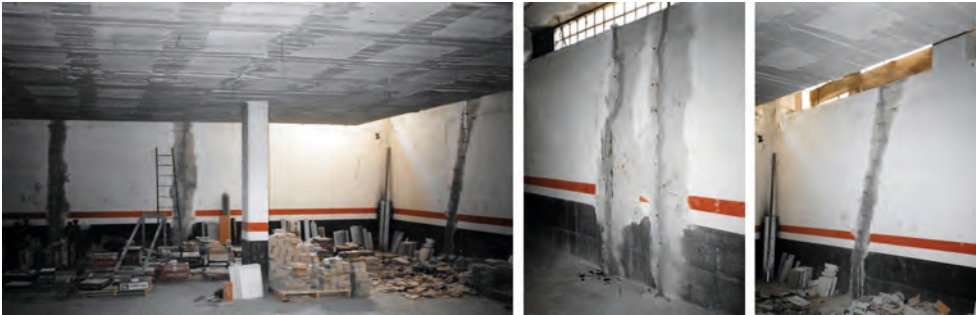
Fig. 8.6. Reparación de grietas de retracción hidráulica mediante inyección de resinas epoxídicas en los muros de hormigón perimetrales en la planta sótano de un edificio residencial.
