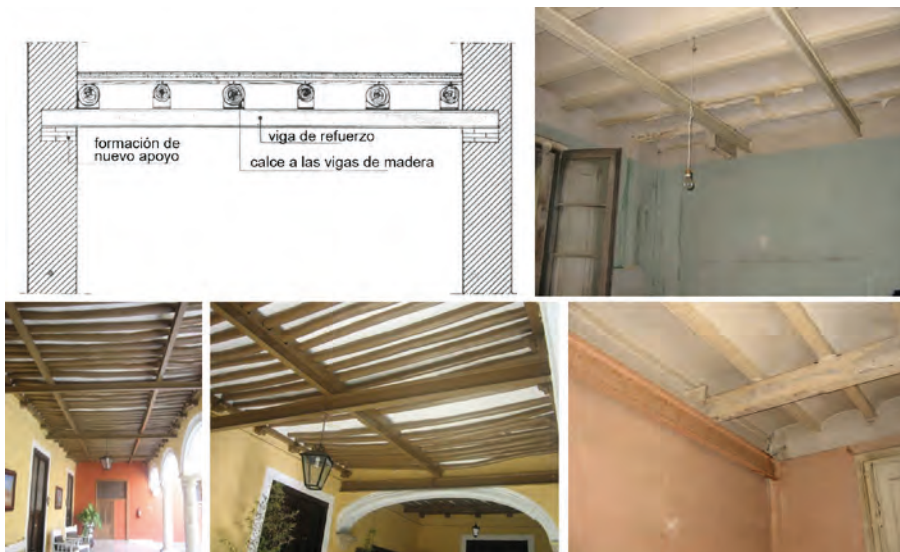
Fig. 18.8. En el gráfico y la foto superior, disposición de perfiles metálicos transversales a las viguetas de madera y apoyados en los muros transversales. En las fotos inferiores, los parteluces metálicos de refuerzo apoyan a su vez en vigas apoyadas en los muros de carga coincidentes con los de los forjados.
