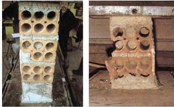
Fig. 4.2. Probetas del muro colapsado de la fig. 4 -1 en las que se percibe el proceso de fractura acaecido.
