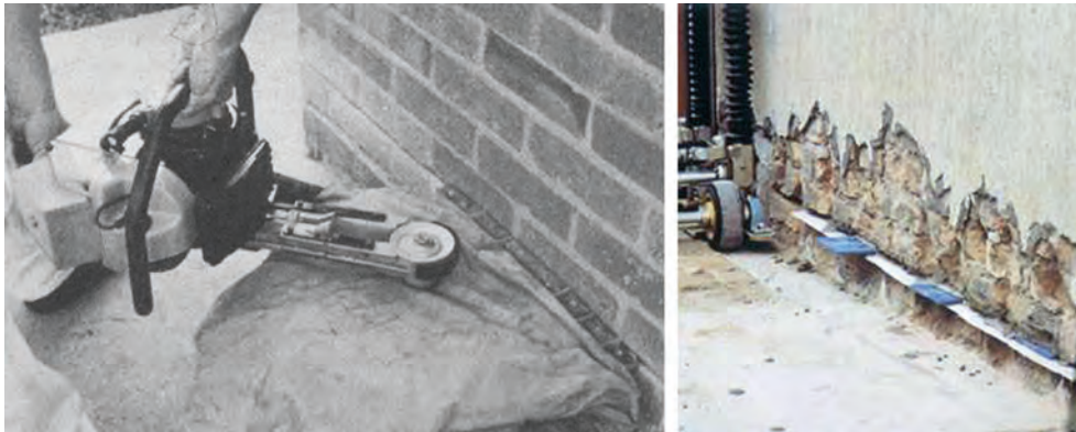
Fig. 33.5. Ejemplo de ejecución de corte con sierra de manejo manual por una junta de la fábrica y disposición de apoyos provisionales hasta su retacado con mortero.
