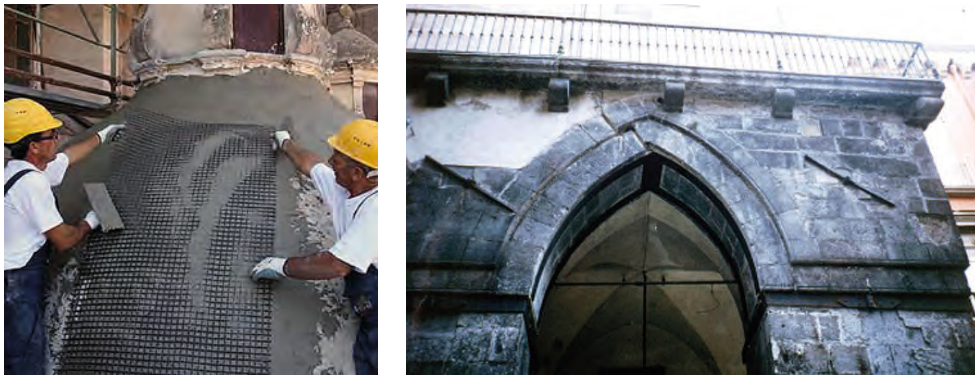
Fig. 25.10. A la izquierda, refuerzo de bóveda con material composite formado de malla de fibra de vidrio y matriz de base cementicia. A la derecha, refuerzo de arco con platabandas metálicas colocadas por su intradós.
