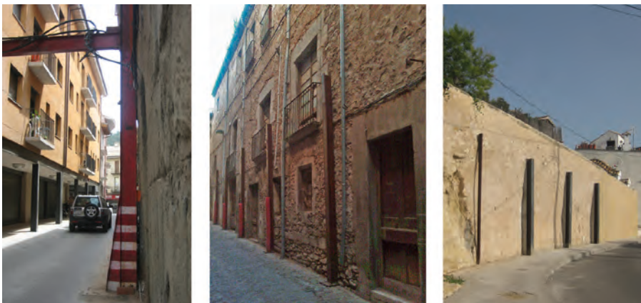
Fig. 2.3. En la foto de la izquierda, apuntalamiento provisional del muro a base de pie derecho y sopanda conectada a la fachada opuesta. En la foto del centro, pies derechos empotrados en el terreno a modo de contrafuertes definitivos. En la foto de la derecha, la misma solución utilizada como soporte de un muro de contención urbano.
