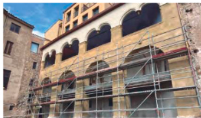
Rehabilitación casa Fábregas, Manresa (BCN)
