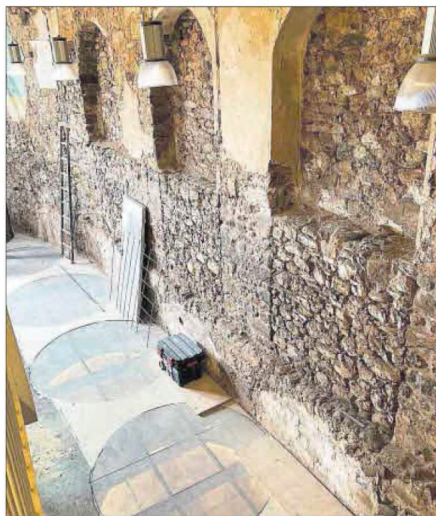
Part de l'espai que es rehabilita, amb 4 de les tines
