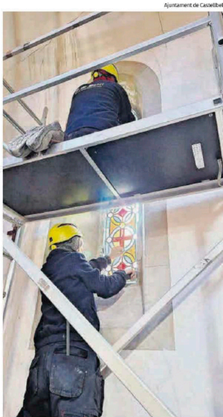
Operaris treballant en la instal·lació dels vitralls
