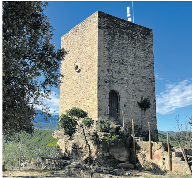
Torre actual restaurada i amb la possibilitat de pujar fins dalt. Font: Santamaria Arquitectes
