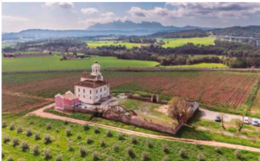
Rehabilitación Torre Lluvià, Manresa (BCN)
