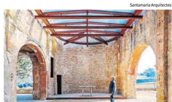
Nau central de l'església de Sant Esteve amb la coberta de vidre
